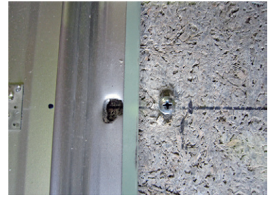
野地板直留め構法確認試験
