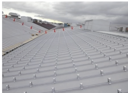
瓦棒ぶき屋根の改修
