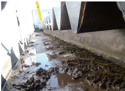
谷どい・汚泥状態の堆積物
