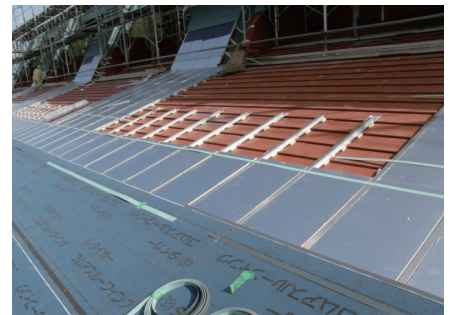
横ぶき屋根の改修
