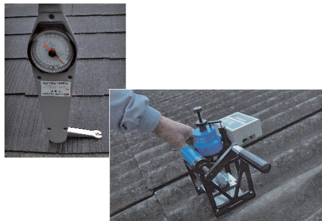
写真3 既存の屋根上での引き抜き強度試験の例
