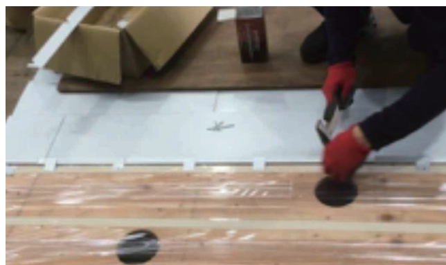
ふき材を吊子留め
