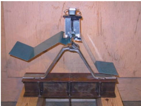
図7 試験体の破壊状況の例
