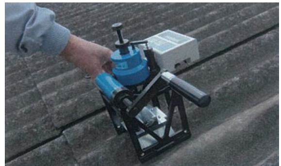
図14 既存フックボルトの耐力調査の例
