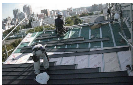
断熱改修工事現場
