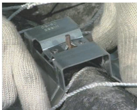
写真-1 弊社 波型スレート改修／間接固定工法 『エパールーフ®やまなみ®サドル工法』
