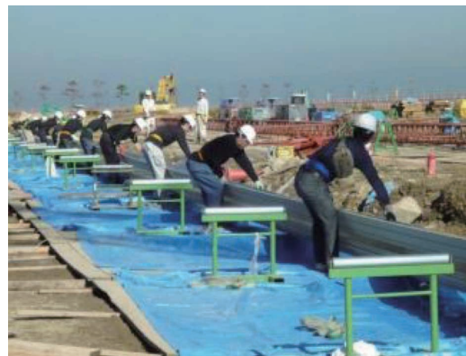
写真-2 現場成型状況
