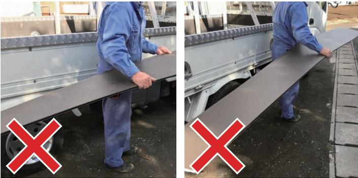
金属サイディングは水平にして運搬すると変形及び折れてしまう可能性があります。
