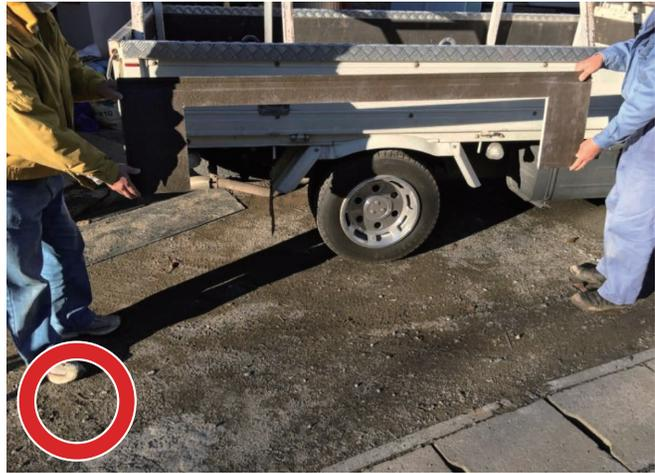
切り欠いた金属サイディングは垂直にして運搬して下さい。二人で運搬するのが望ましい。
