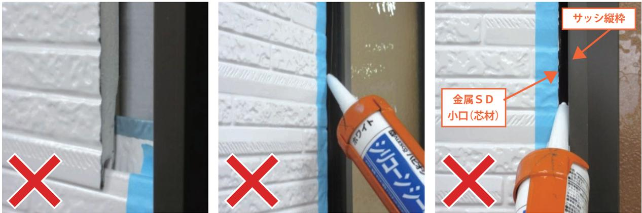
金属サイディングの芯材部分にシーリング施工を行うと施工後、シーリングと芯材部分が剥がれる可能性があります。
