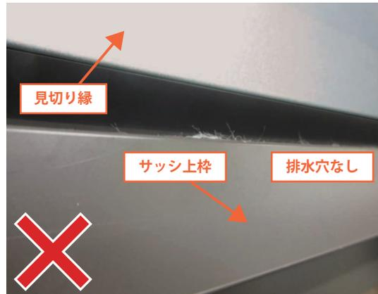
見切り縁の水抜き処理を行わないと、雨水等が屋外に十分排水されない可能性があります。
