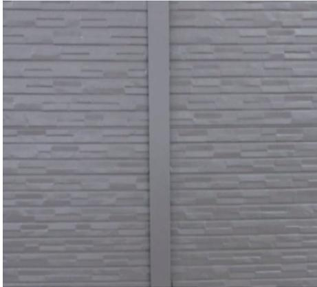
施工時、ジョイナー上部材をしっかり押し込まないと金属サイディングとジョイナー上部材の間に隙間が生じる可能性があります。
