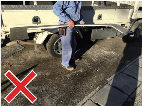
切り欠いた金属サイディングを水平にして運搬しますと変形及び折れてしまう可能性があります。
