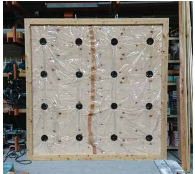
写真1 ふき材を留め付ける前の野地板と気密ビニルの状況
