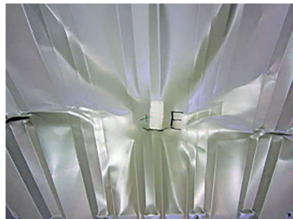
b. ミサイルEの衝撃による亀裂（一般部、屋外側）
