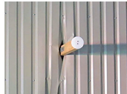
c. ミサイルEの貫通（重ね部、屋外側）
