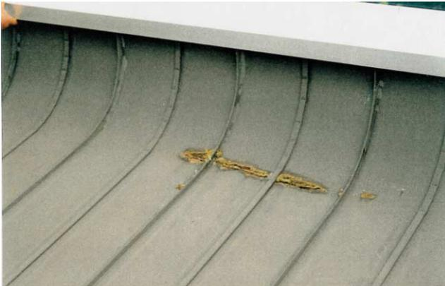
屋根アール曲げ部の腐食状態（施工：7年経過）
