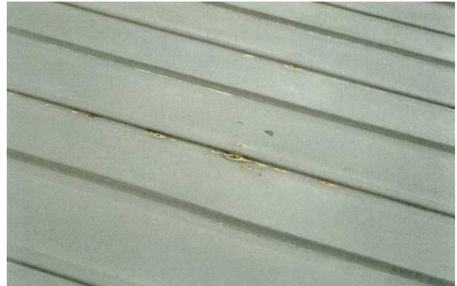
屋根フラット部の腐食状態（施工：7年経過）
