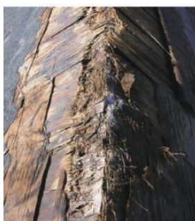
図5 野地板(棟部) 結露により合板が腐朽している。
