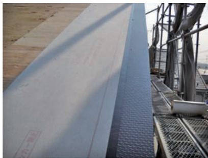
②軒先・ケラバに通気部材を留め付けます。
