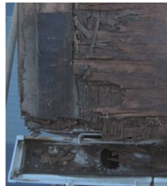
図10 化粧スレート(軒先・ケラバ部) 合板が腐朽によりボロボロとなっている。
