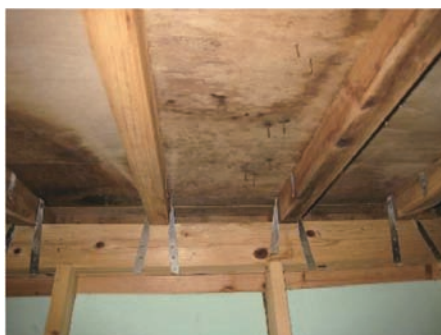
図9 野地板 屋根断熱の断熱材を剥がしたところ。結露水により野地板が濡れている。
