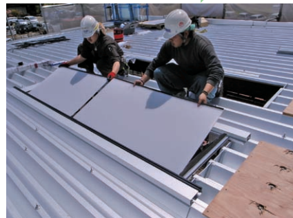
拡散板の取付
