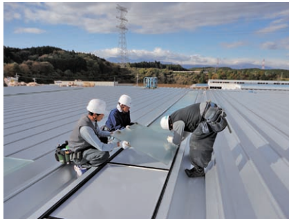
ガスケット・ガラス挿入
