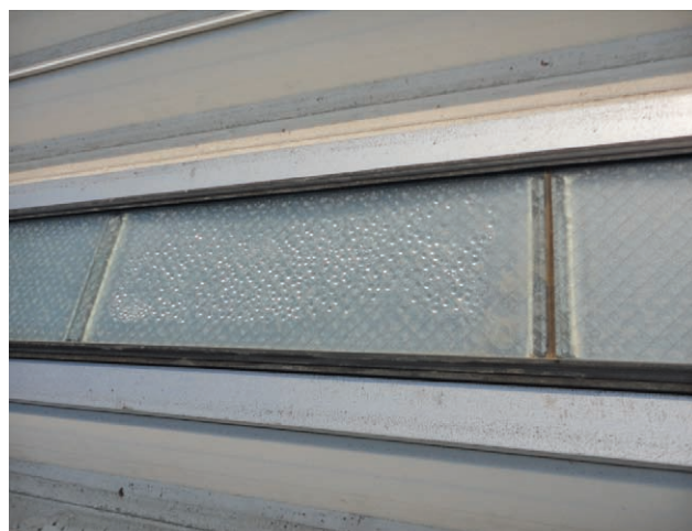
ガスケットの劣化で 嵌合部から雨水が侵入しガラス裏面に結露したもの
