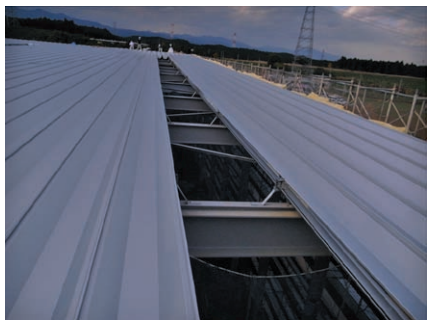
開口部確認 断熱見切り、吊子、はぜ締め
