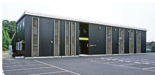
ネオマ耐火スパンウォールで 施工したブラザー印刷(愛知県)
