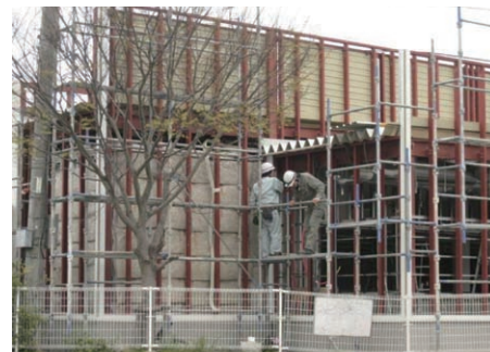
グラスウールの充填工法
