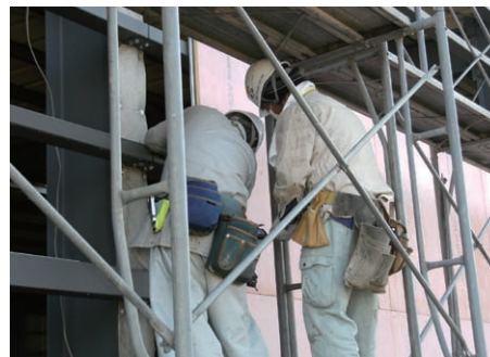
ネオマ耐火スパンウォール外張断熱工法
