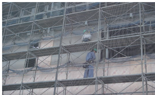
ネオマ防火ボードの施工
