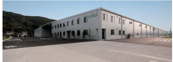
センコー(株)延岡支店日向PDセンター・ネオマ防火ボード施工例
