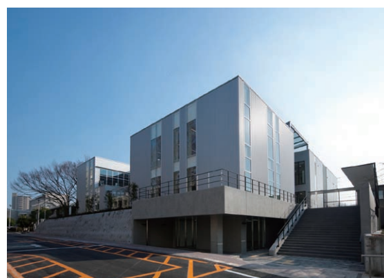
名古屋大学南部食堂棟(愛知県)
