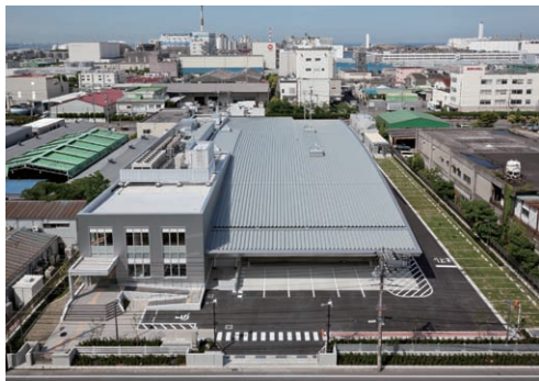
千葉市新港学校給食センター (千葉県)
