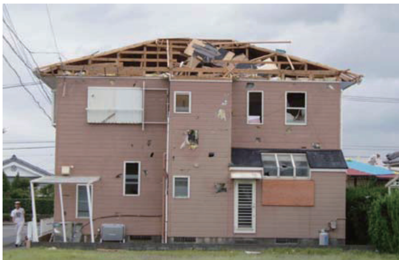
写真1 台風0514での飛来物による被害 (宮崎地方気象台提供)
