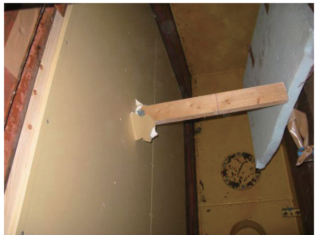
(18) 試験体No.6、ミサイルDの内装材貫通
