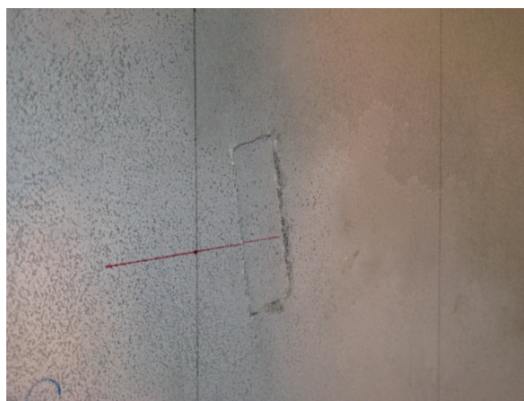
(12) 試験体No.5、ミサイルCの衝突痕
