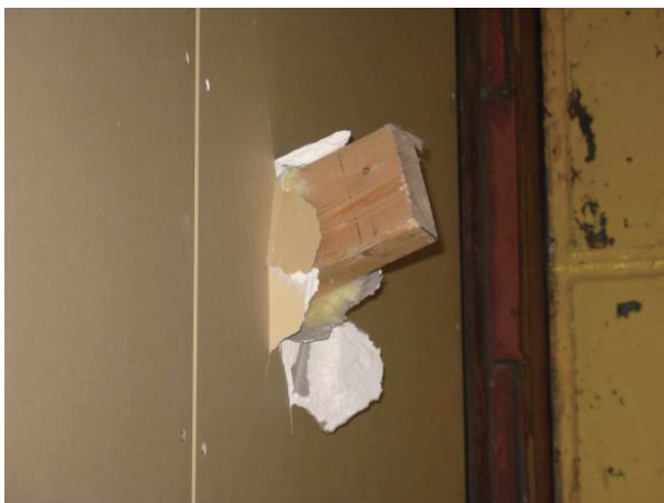
(3) 内装材への貫通(試験体No.1)
