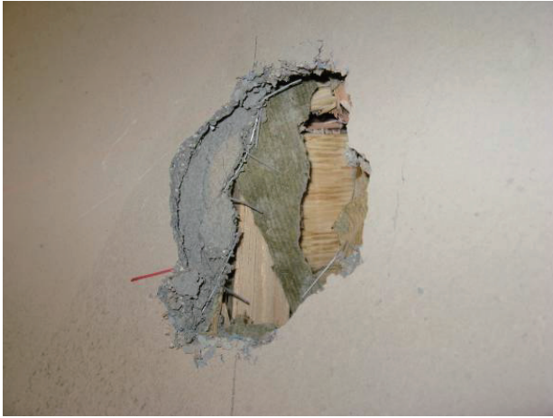
(13) 試験体No.5、ミサイルDの貫通痕
