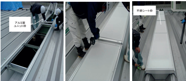
アルミ製ユニット枠の設置 不燃シート枠の取付け 不燃シート枠の取付け後
