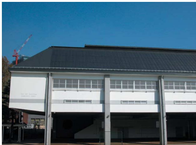
立教小学校体育館
