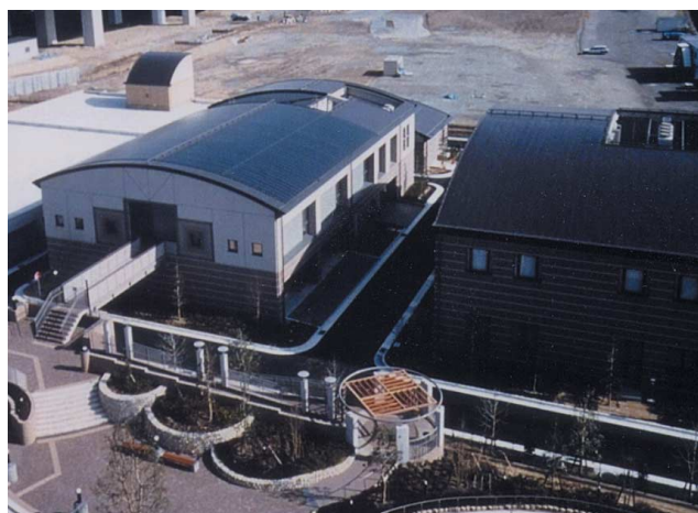
南芦屋浜下水処理場
