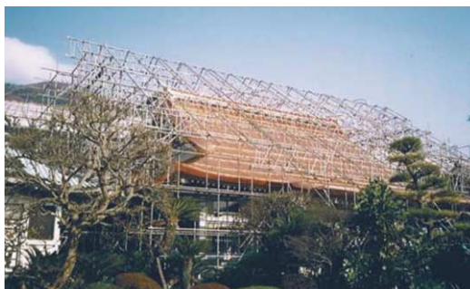
写真14 素屋根の撤去
