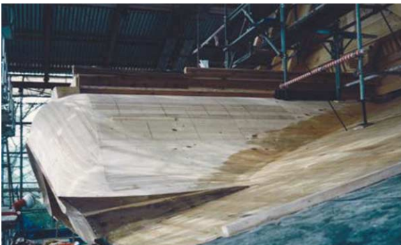
写真7 木下地の例（唐破風の箕甲）
