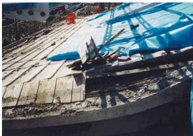
写真11 既存屋根の下地（RC造の瓦屋根）
