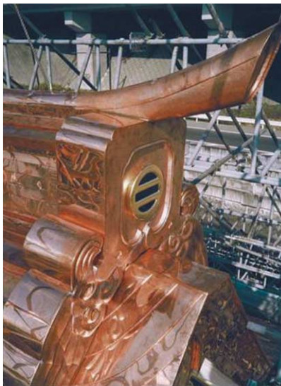
写真13 役物の製作と取り付け
