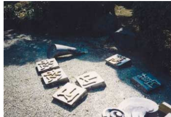
写真9 役物は取りはずして個々に採寸
