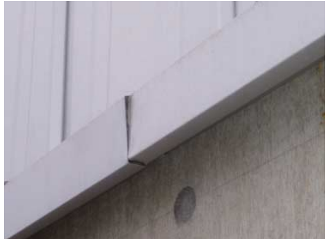
写真6-1 腰水切部接続部のテストサンプル
