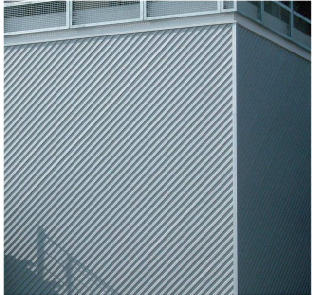
写真8 外壁仕上り・角波サイディング
