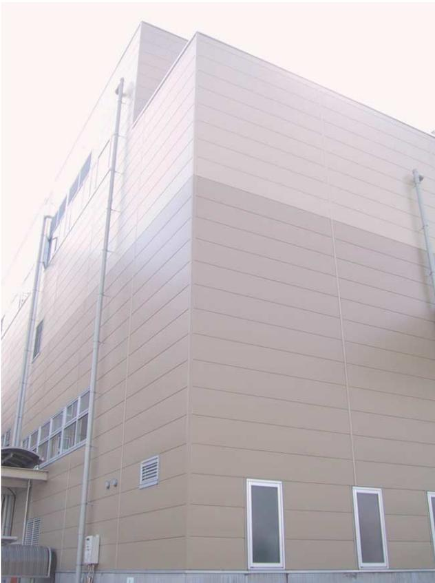
写真9 金属サイディング（広幅製品）を中層建物の外壁に使用した例
