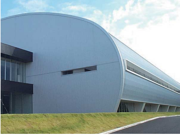
写真7 軽快な外観の壁面
