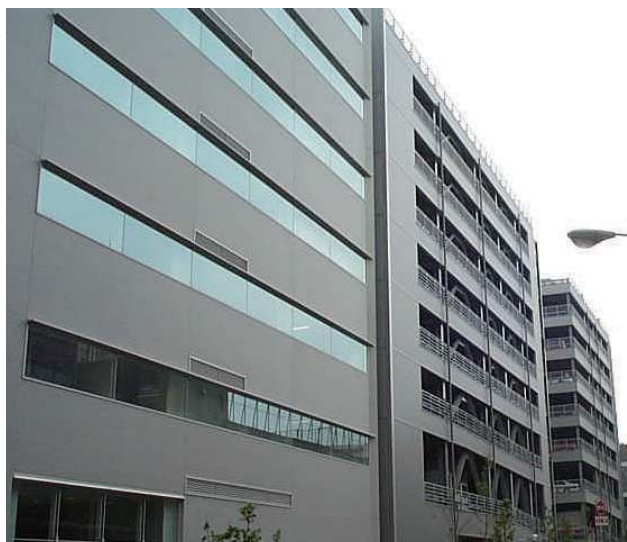
写真2 中層ビルの外装で使用、3棟とも （スパンドレル）
