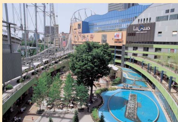
●東京ドームシティ遊園地「ラクーア」（東京都） スパンドレル カラーGL鋼板
