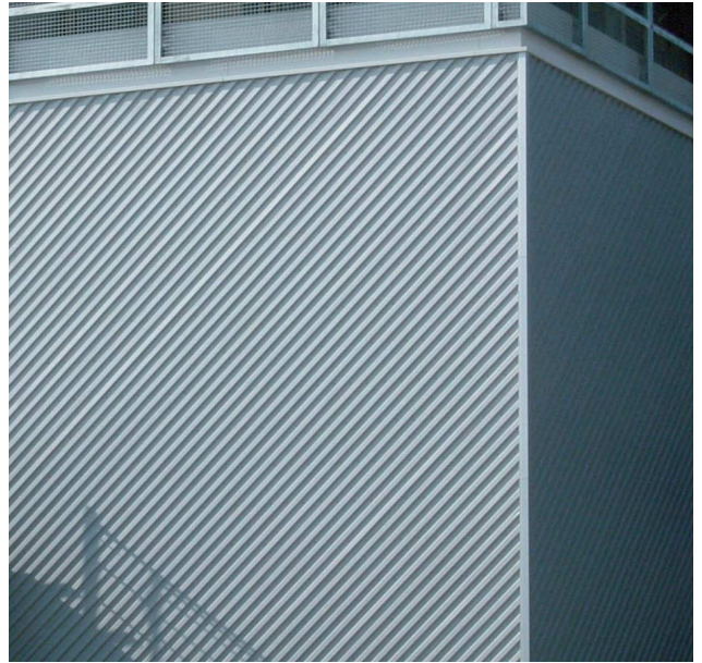
写真8 外壁仕上り・角波サイディング
