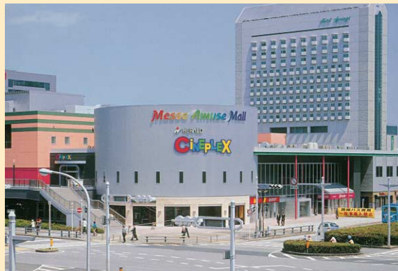
●メッセ・アミューズ・モール（千葉県） 大波 カラーGL鋼板
