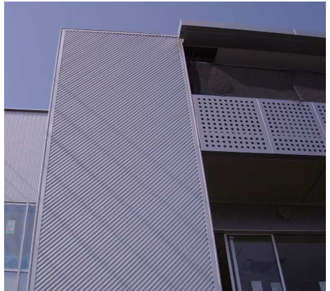
写真10 外装として使用した例（スパンドレル）
