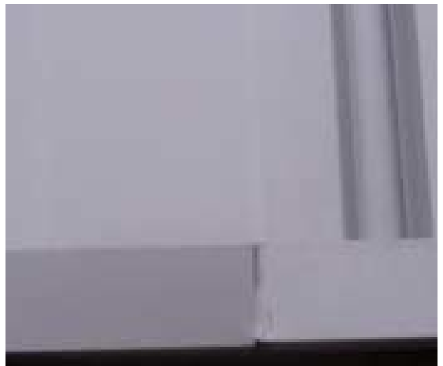
写真6-2（写真6-1）のような不具合が生じると 太陽光線の反射角度により、色調が異なっ たように見える
