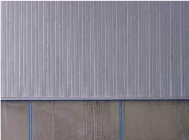
写真4-1 腰水切の納め（面戸のふくれとなるひずみ）
