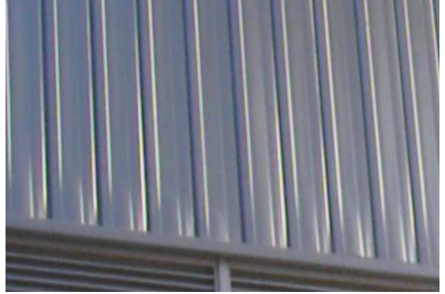
写真5 面戸によるふくれ現象の影響で色違いに見える。 太陽光線の働きによっては、全く違ったような 製品に見えることもある（陰影部）
